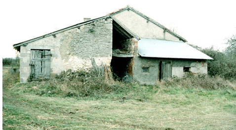
Ancien hangar à tuiles transformé, à la Tuilerie-de-Peufavard, vu au début des années 1990.
