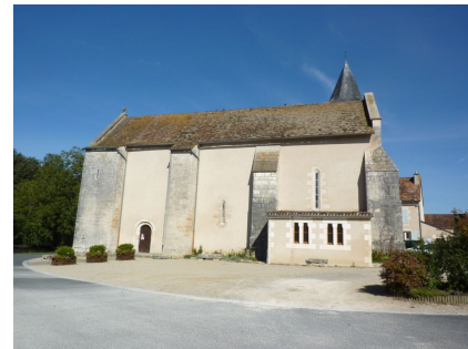
Église vue du sud.
