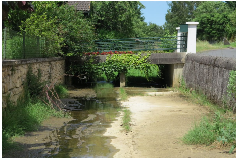
Passage canalisé d'un ru, rue du Petit-Ruisseau et ponceau.
